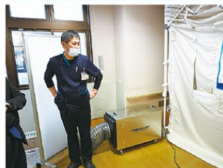
西3病棟をコロナ専用病棟にする準備を開始。空気感染隔離ユニット「ミンティ」を設置しました。
