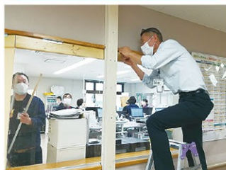
コロナ専用病棟運用開始。ナースステーションはじめ、改修を行いました。
